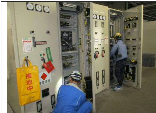
13. 変電所健全性確認
