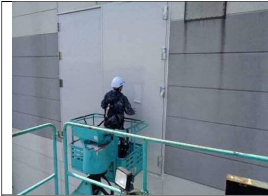
2 2. 建屋老朽化補修 外部扉更新
