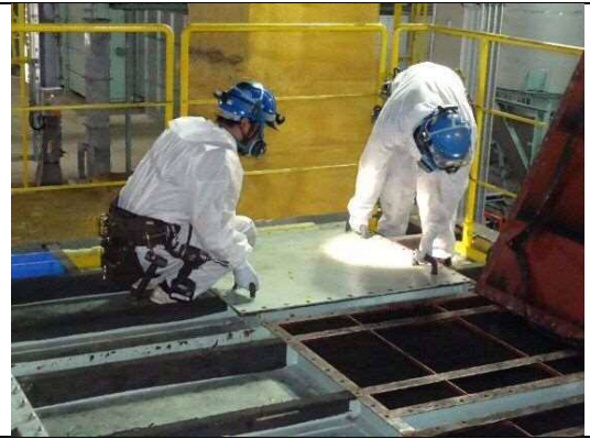
2 3. 換気空調設備活性炭交換
