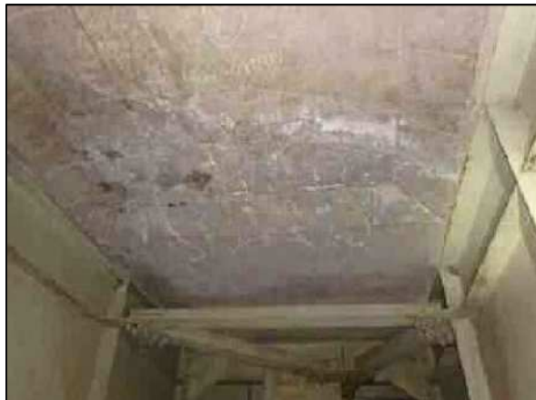
鋼製橋脚の腐食
