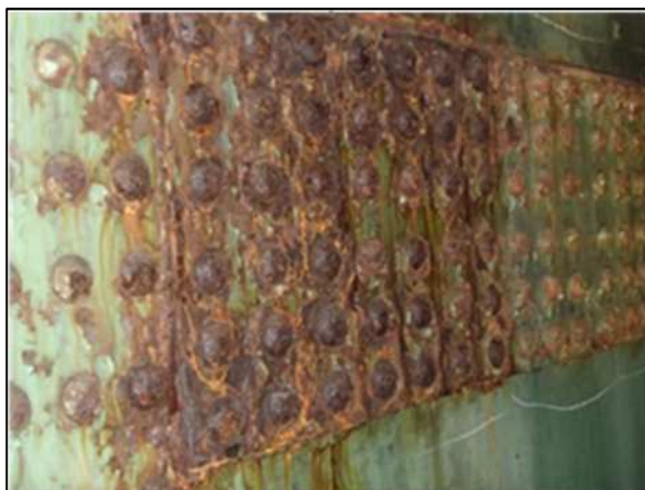
鋼製橋脚の腐食
