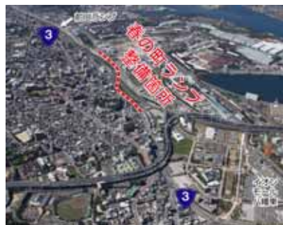
国道3号黒崎バイパス (春の町ランプ整備箇所)
