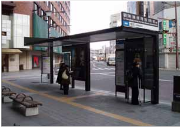
魚町バス停(上屋・ベンチ・バスロケーションシステム付)
