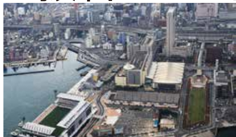
西日本総合展示場 北九州国際会議場
