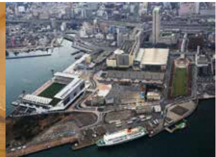
西日本総合展示場・北九州国際会議場
