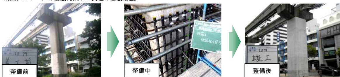
橋梁、モノレールの耐震対策(RC支柱の耐震補強)
