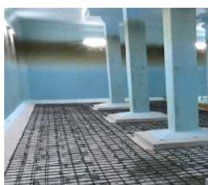
配水池の耐震化
