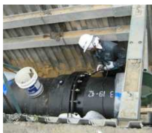
水道管路の耐震化(耐震管布設)
