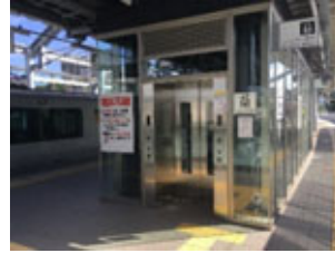
JR折尾駅(エレベーター)
