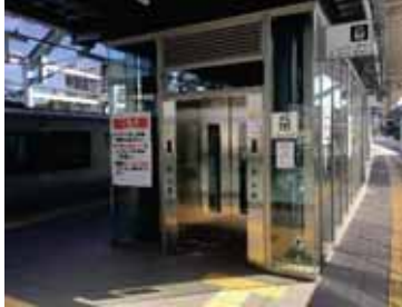
JR 折尾駅(エレベーター)
