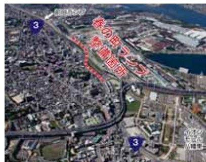
国道3号黒崎ハイパス (春の町ランプ整備箇所)
