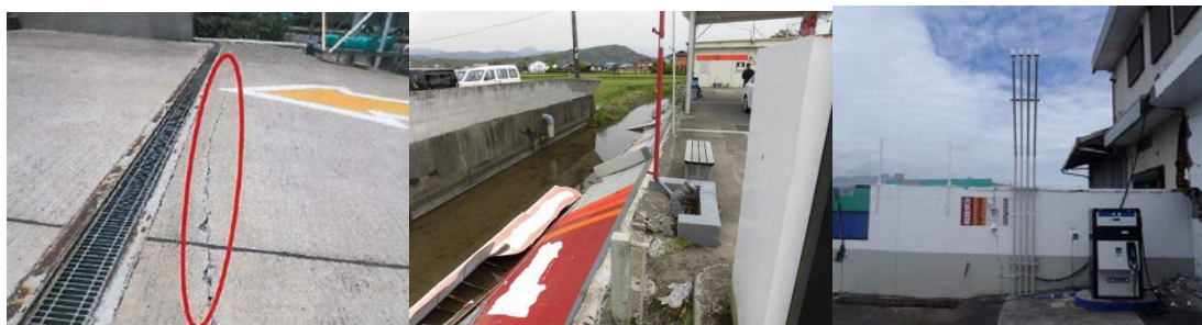
写真9 給油取扱所での被害状況
