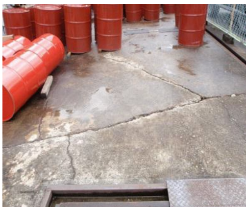
写真 8 屋外貯蔵所における被害状況
