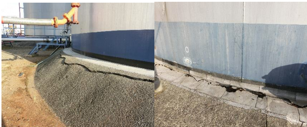
写真 6 屋外タンク貯蔵所における被害状況
