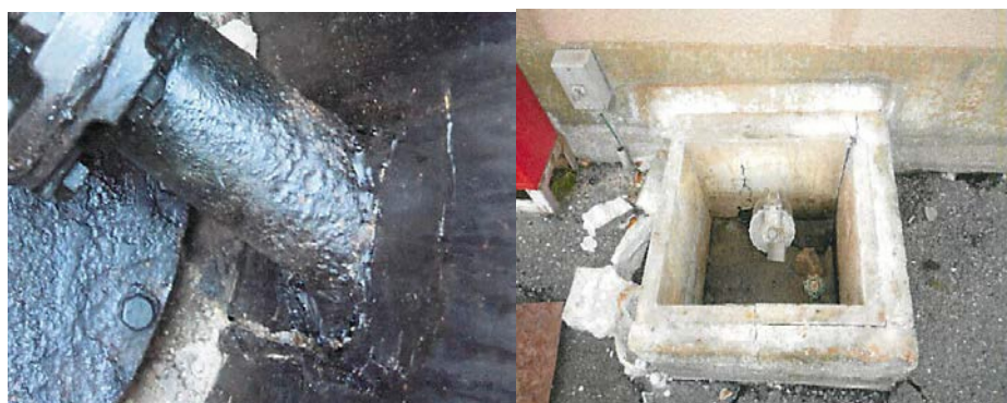
写真 7 地下タンク貯蔵所における被害状況
