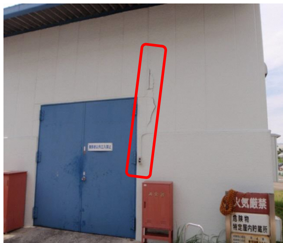
写真5 屋内貯蔵所の被害状況
