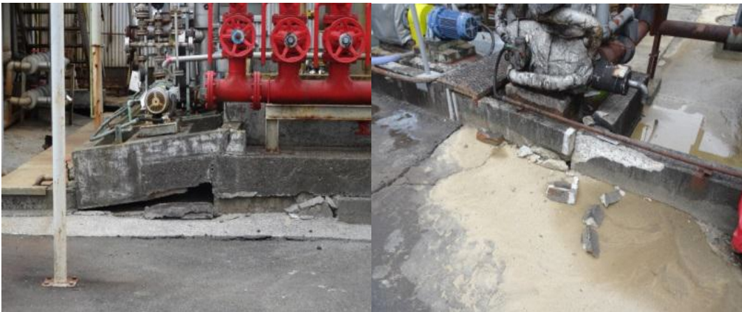
写真4 製造所における被害状況
