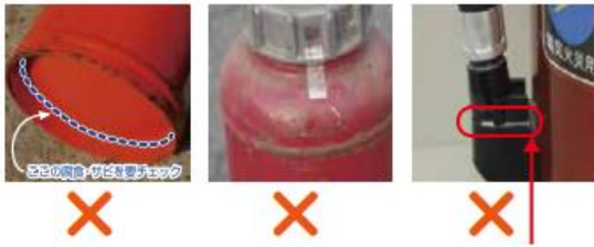
底部の腐食 著しい腐食 消火薬剤の漏れ
