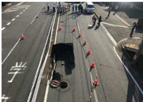
下水道管渠破損による道路陥没
