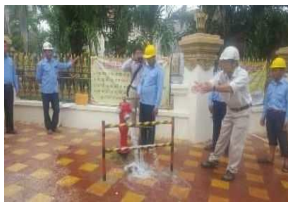
漏水対策指導
