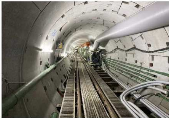
整備中の昭和町雨水貯留管
