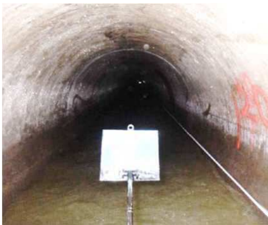
耐震化前の下水道管渠
