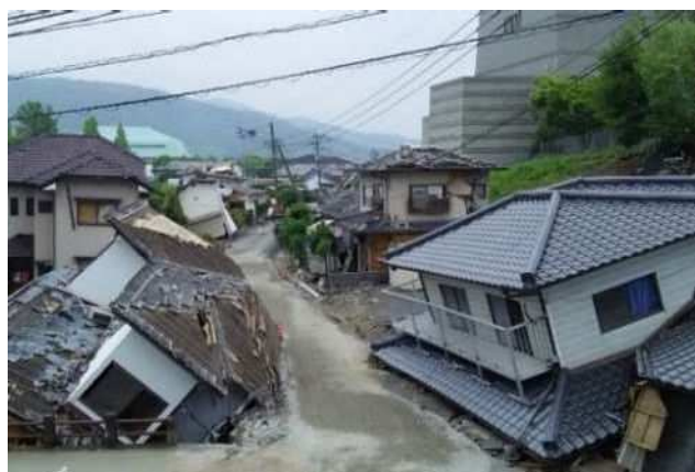
平成 28 年熊本地震 被災状況
