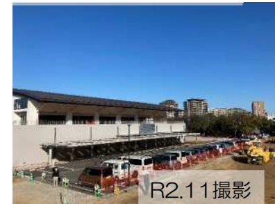
駐車場整備状況
