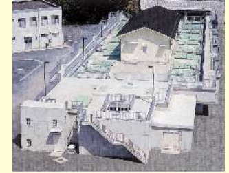
高度浄水施設(穴生浄水場)
