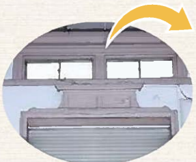
▲解体直前写真
