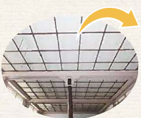
▲解体直前写真
