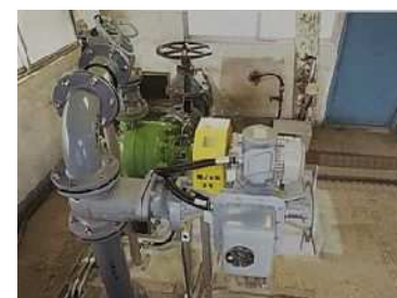
ポンプ設備更新後
