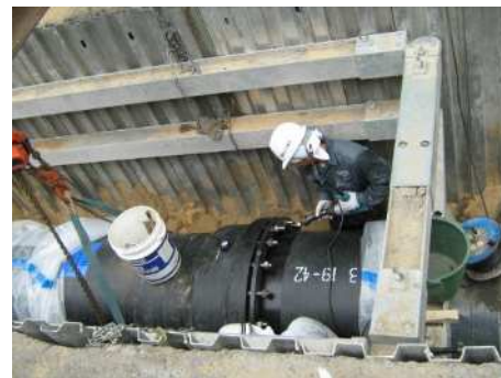
耐震管布設状況
