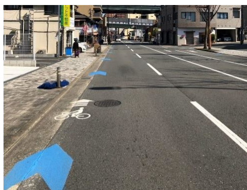
＜車道混在の整備例＞ （小倉北区：県道堅町到津線）
