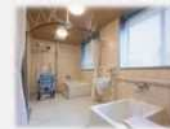
浴室リフト・天井 走行型リフト ハンディケア
