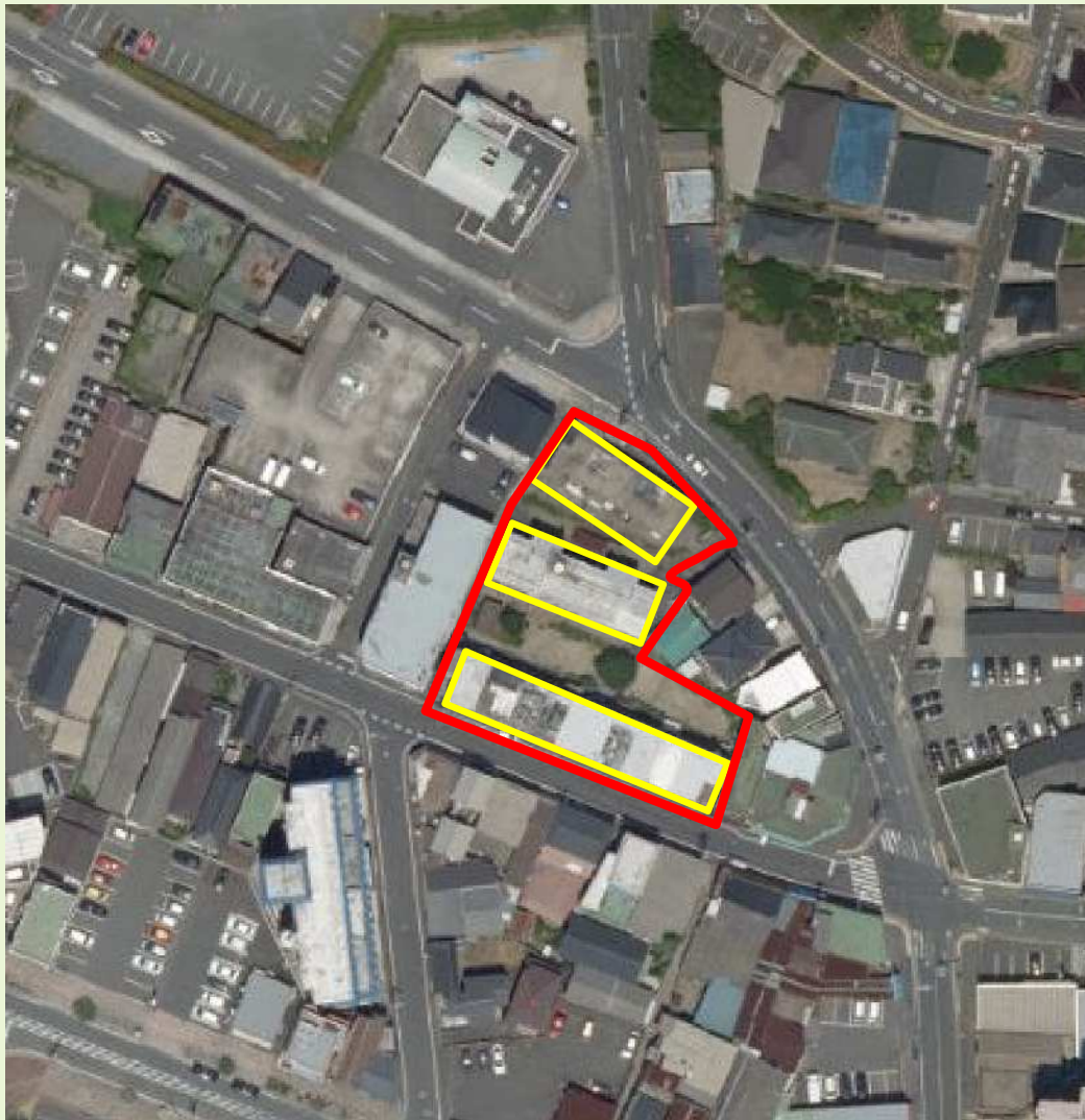
白川町(しらかわまち)団地 昭和32年建設 3棟 42戸
