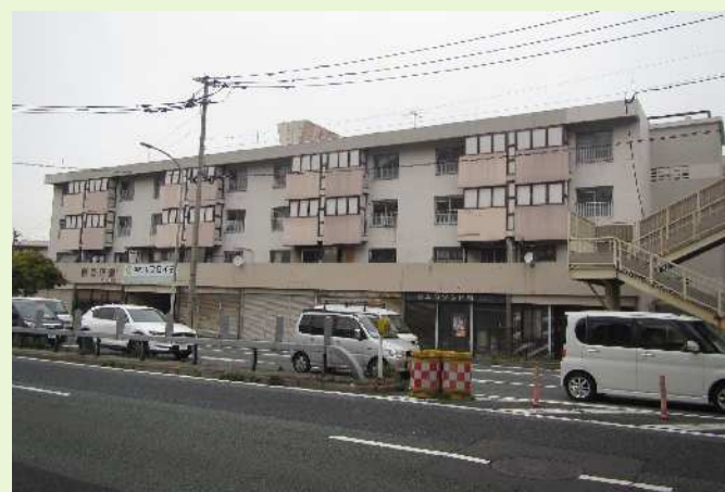
5 棟（区分所建物）
