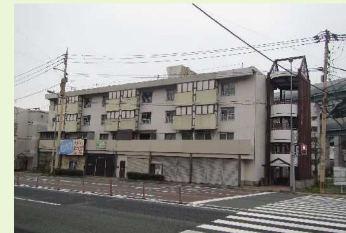
7 棟（区分所建物）
