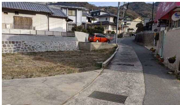
【水路に蓋を施し、車道として使用、もともとは右側のアスファルト部が道幅】
