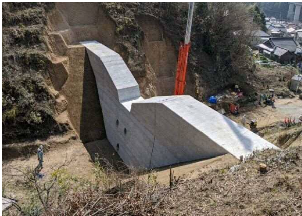
【砂防堰堤完成：広島県発注分】
