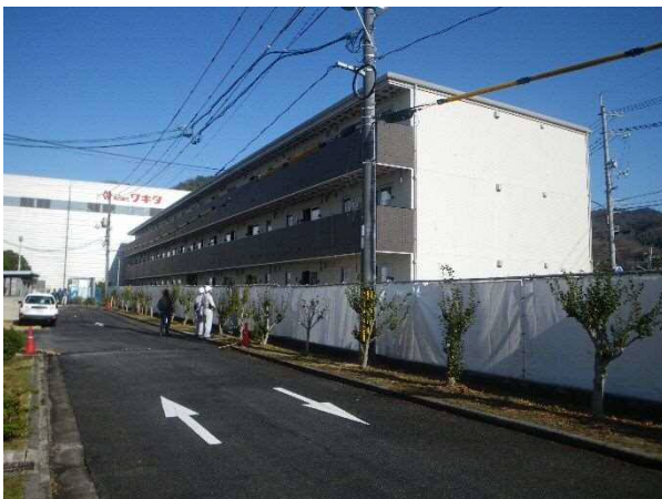
(小屋浦地区集合住宅：31戸)
