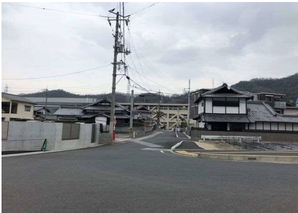
【用地買収後の整地状況： 車道拡幅および歩道設置】
