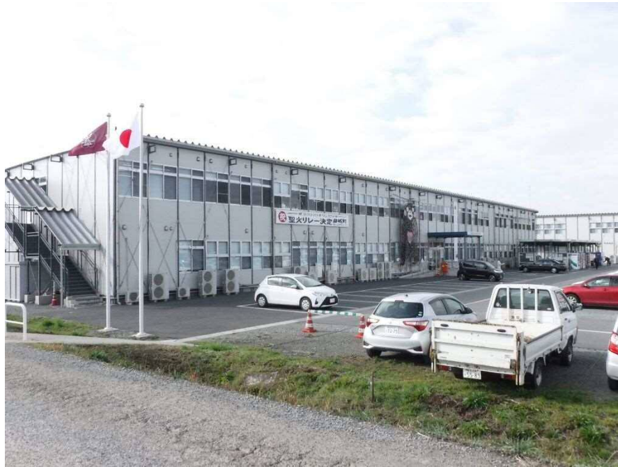
(益城町役場仮設庁舎)
