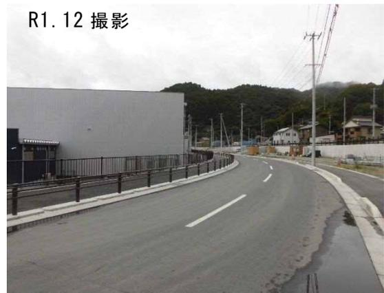
写真. 2 釜石駅東前線（6 mかさ上げ後に従前位置に道路を再整備）
