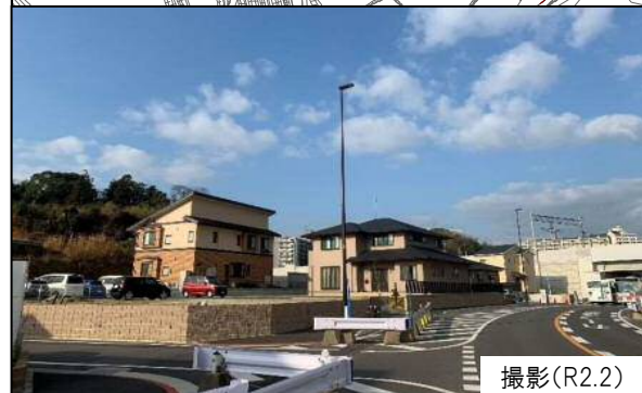
宅地整備工事（堀川町地区） 撮影(R2.2)
