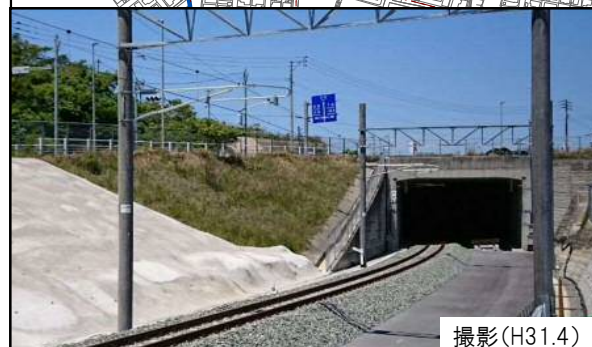
トンネル終点部(国道3号付近) 撮影(H31.4)
