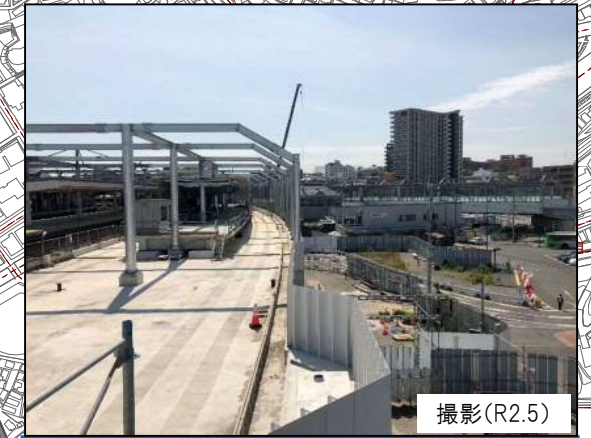
鹿児島本線高架工事 撮影(R2.5)
