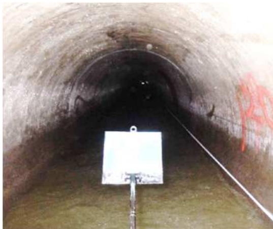
耐震化前の下水道管渠
