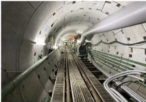
整備中の昭和町雨水貯留管
