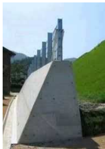
土砂災害対策の事例
