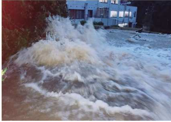
水道管の漏水事故
