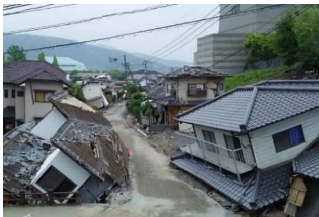
平成 28 年熊本地震 被災状況
