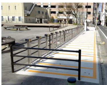
＜堺町地区の駐輪施設＞
