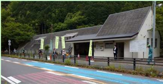
＜河内サイクリングセンター＞
