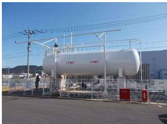
高圧ガス製造施設
