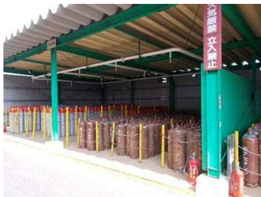
容器貯蔵施設
