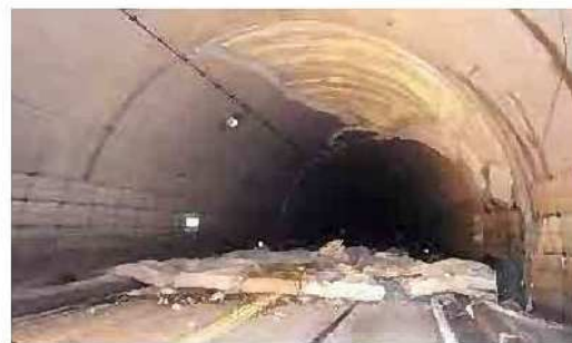
断層変位による損傷状況
