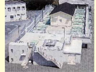
高度浄水施設(穴生浄水場)
