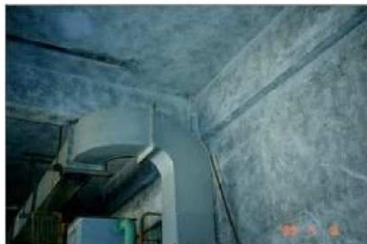
機械室の壁・天井の断熱
