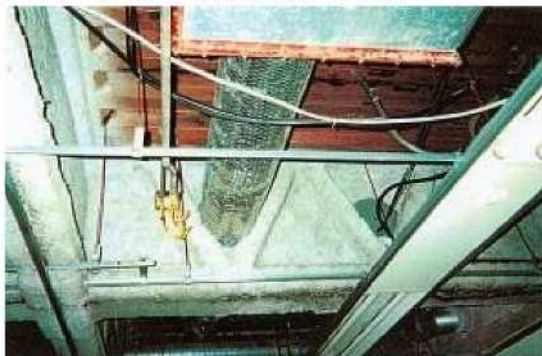
鉄骨造の梁・柱の耐火被覆
