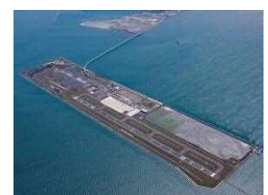
北九州空港全景
