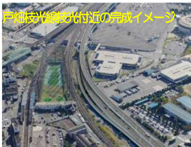
～主要幹線道路の整備～
