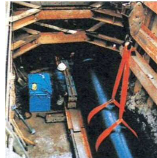
水道管更新作業
