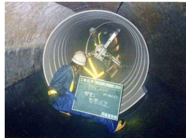
下水道管の更新例
