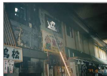
市場内で火災発生（H11年）
