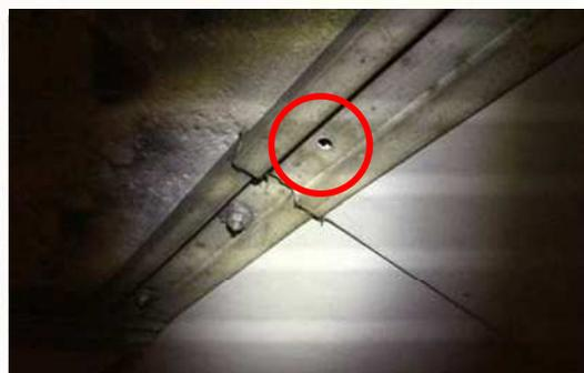
付写真-1.10 導水樋の止め金具が脱落した例
