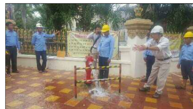
(漏水対策指導)
