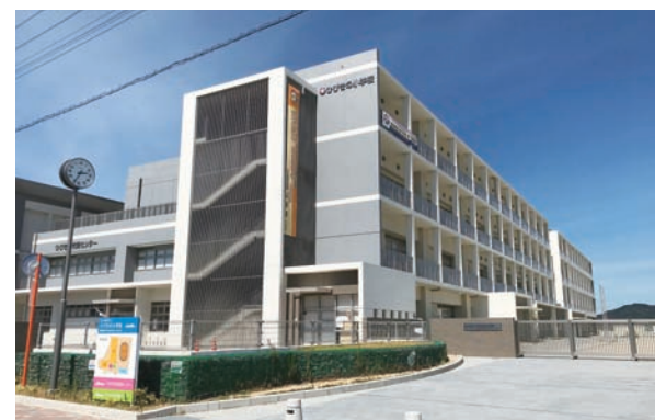
ひびきの小学校(平成29年4月開校)
