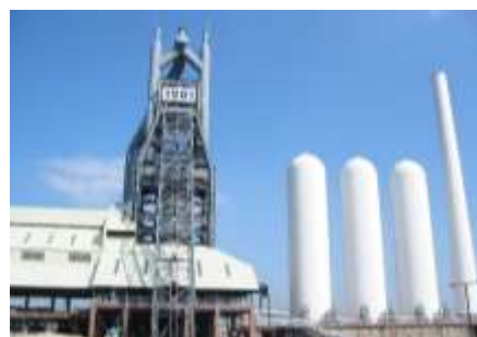
東田第一高炉跡
