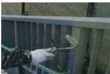
塗装塗り替え工
