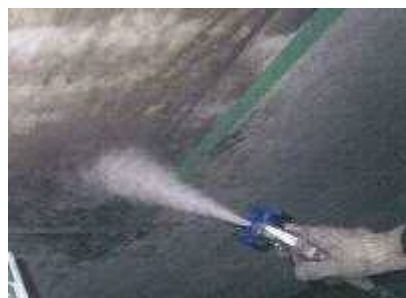
コンクリート表面保護工
