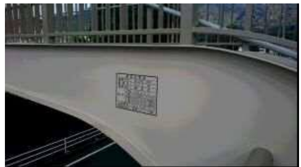
写真 3.3 修繕後の状況
