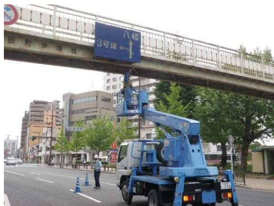
(a) 高所作業車による点検状況
