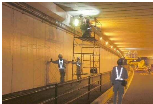
(b) 移動足場による点検状況
