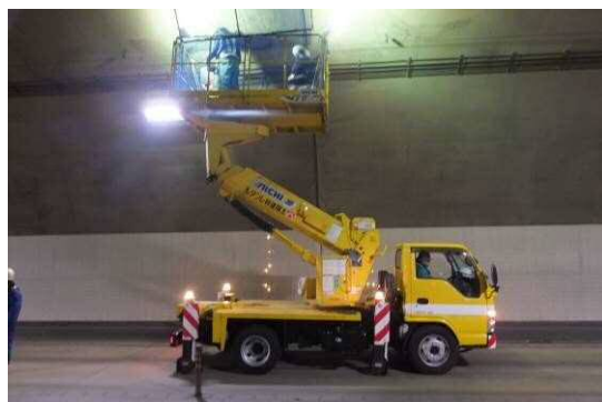
(a) 高所作業車による点検状況
