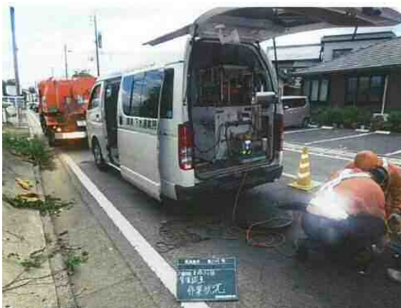
詳細調査状況
