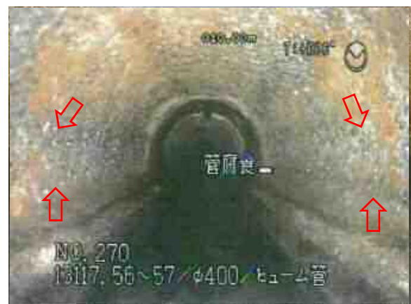
管内骨材露出状況 (TVカメラ調査)
