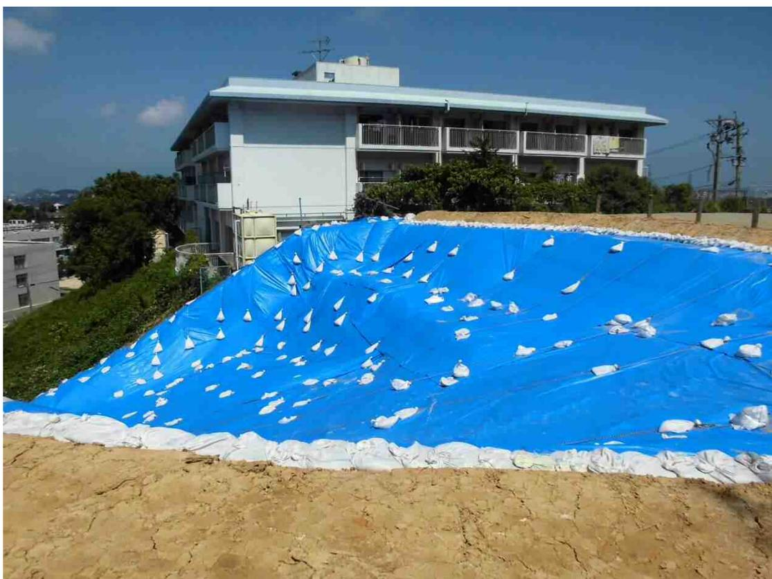
小森江浄水場跡地の法面崩落事故（近接家屋の前面道路）
