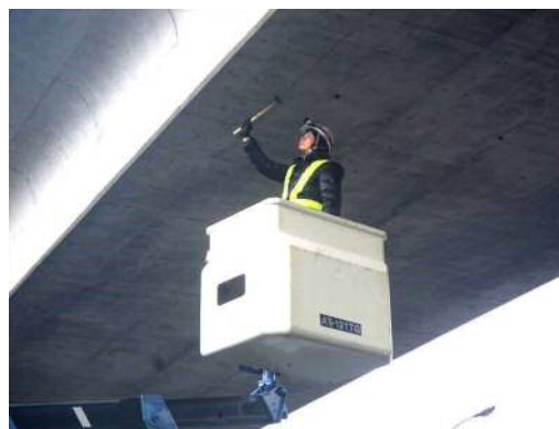
b) 打音点検の状況
