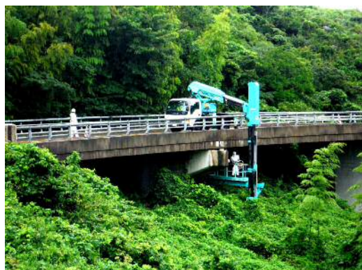
(a) 橋梁点検車による点検状況
