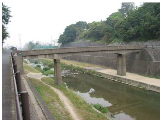
写真 3.2 修繕前の状況
