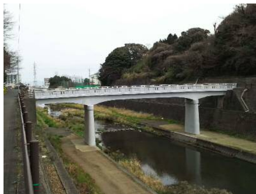
写真 3.3 修繕後の状況
