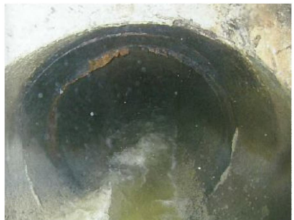
管内状況（マンホールより目視）
