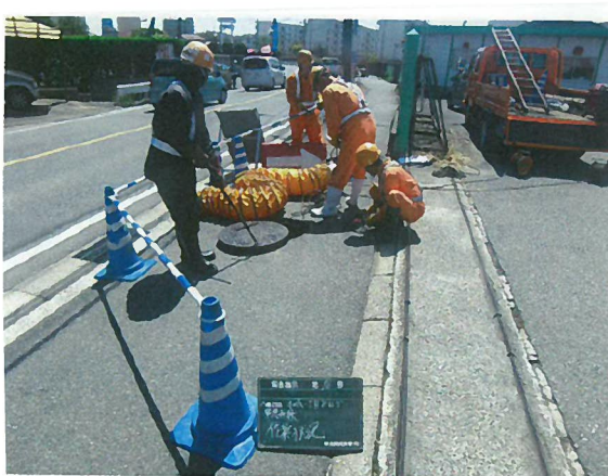
緊急点検状況
