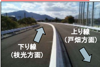
都島展望公園付近(土工部)
