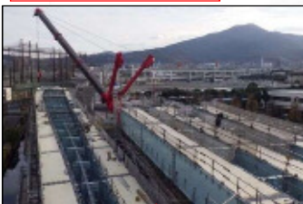
枝光駅付近(橋梁部)
