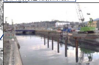
牧山橋付近(橋梁架替)
