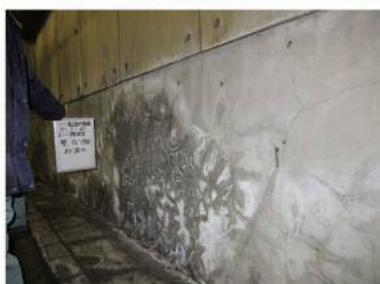
地下1階 壁の漏水・ひび割 (多数)
