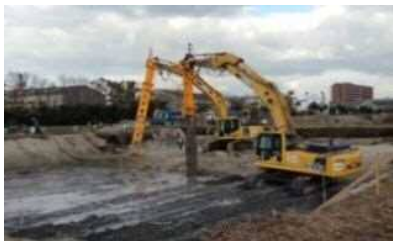
地盤改良工事状況
