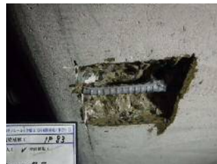
断面修復 施工状況
