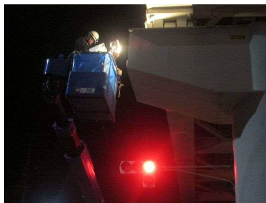
高所作業車による点検状況
