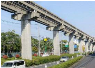
PC軌道桁・RC支柱
