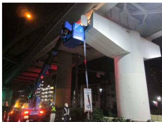
高所作業車による点検状況
