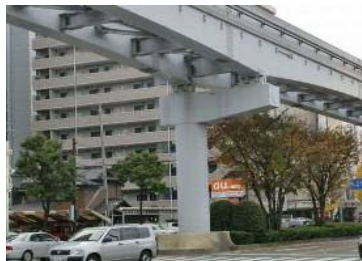
鋼軌道桁・鋼支柱
